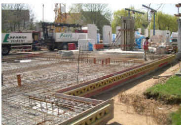
Beginn des Neubaus
